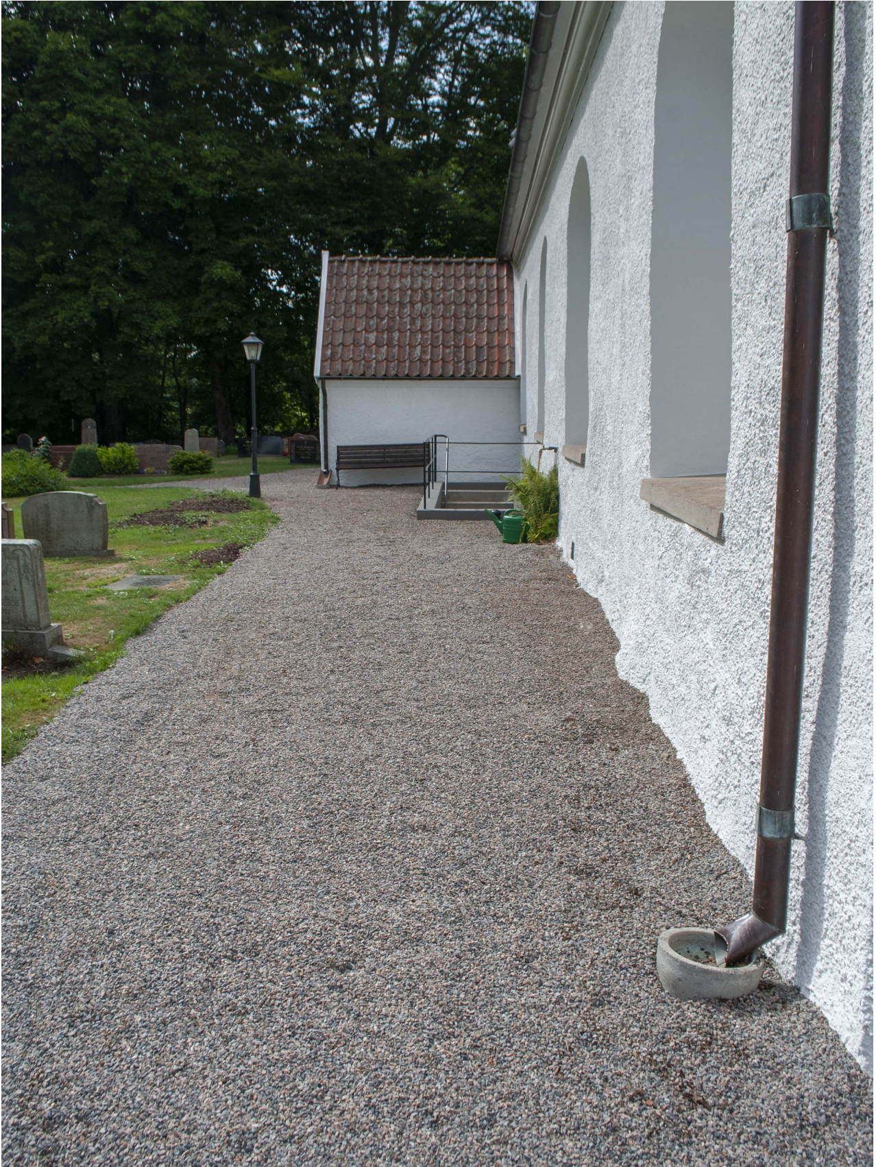
Nya ledningar går numera under grusgången längs kyrkans södra sida.
